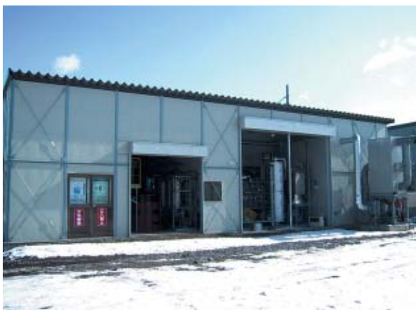
処理施設外観（室蘭製作所内）
