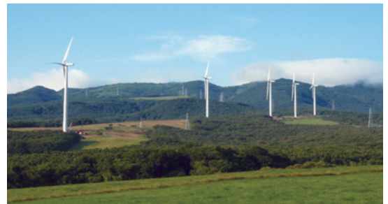
伊達ウインドファーム 場所……北海道伊達市 J82……5基(ロータ径83.3m、定格出力2,000kW) 2011年11月より営業運転開始
