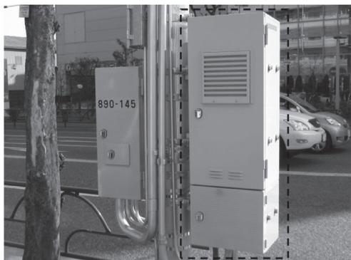
図 23 信号機用燃料電池電源の外観写真
