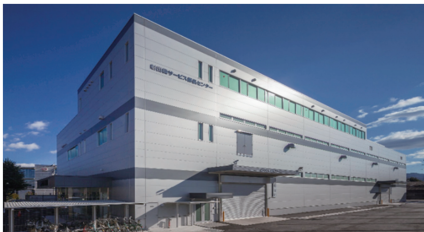
射出機部品センターの外観
