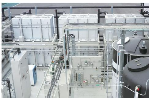
図3 MH タンクの導入事例 (山梨 P2G システム)
