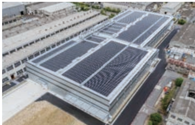
第3機械工場外観
