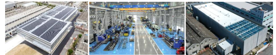
稼働を開始した第3機械工場（左・中）と建設の進む第4機械工場（右）
