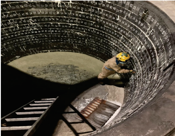
図 2 レーザー距離計を用いた従来の煉瓦測定方法
