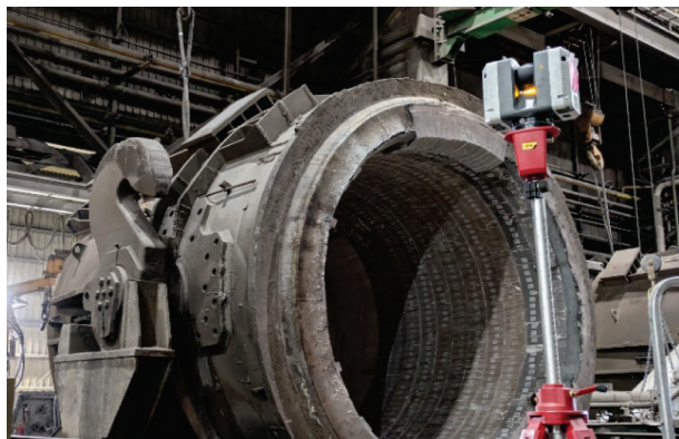
図3 3D レーザー測定状況
