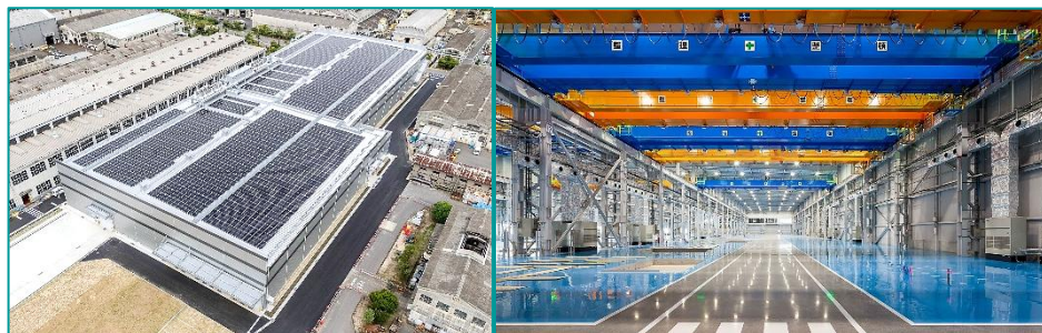
第3機械工場 (10月 建屋竣工)
