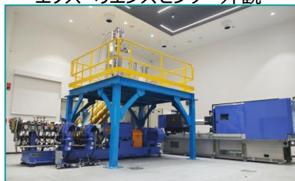
押出機・射出成形機を設置
