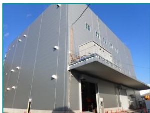
稼働を開始した新組立工場
